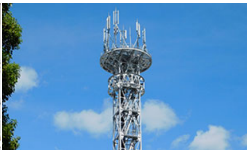
Setor de telecomunicações
