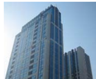
三菱电机自动化中心 Mitsubishi Electric Automation Center
